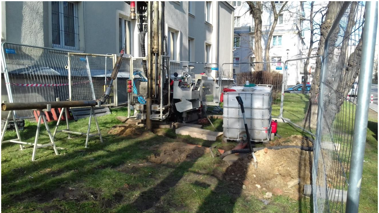
Fotografia 2 Wiercenie rdzeniowane w rurach osłonowych, otwór OW-41.
