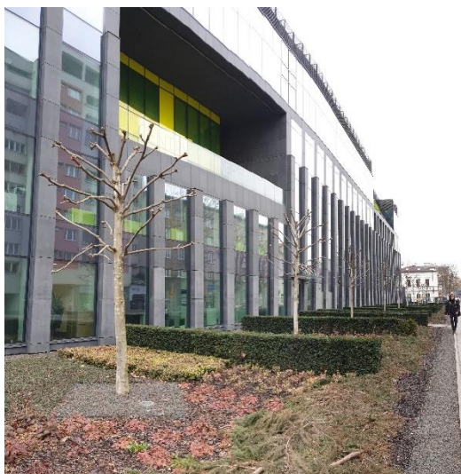
Zdjęcie 41 - Zieleń przed budynkiem Centrum Energetyki AGH
