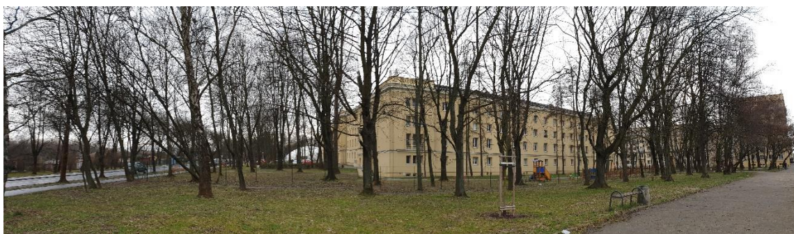
Zdjęcie 12 - Południowo-zachodnia część skrzyżowania Al. Solidarności z ul. Bulwarową
