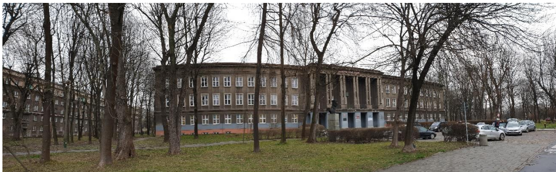
Zdjęcie 10- Zadrzewienie przy Zespole Szkół Mechanicznych nr 3 w Krakowie
